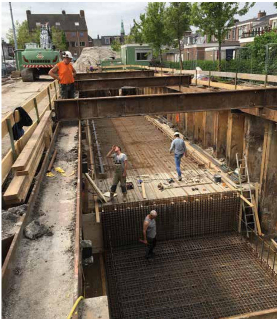
Aanleg van een bunker onder een straat in Lisse voor waterberging. (foto: Arcadis)
